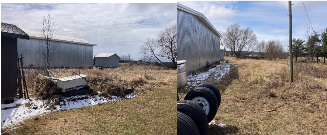
Côté nord du bâtiment du club
