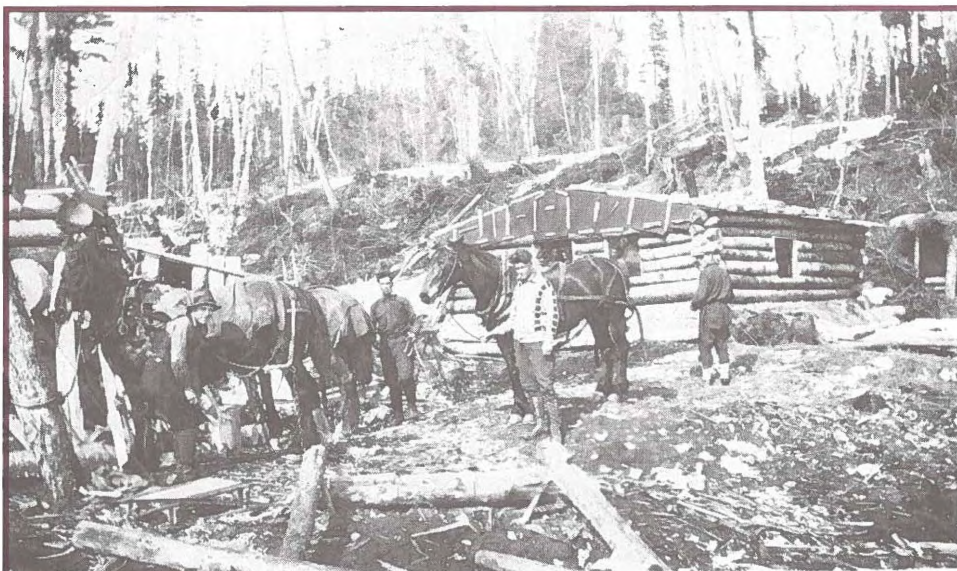
Chantier de bois
