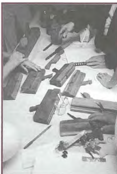
Outils fabriqués par Joseph Vachon en 1936 pour la construction de sa maison dans le rang 6.
