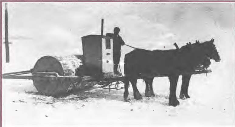
Georges Lemire ouvre le chemin avec un rouleau à neige sur lequel est installé un stage.
