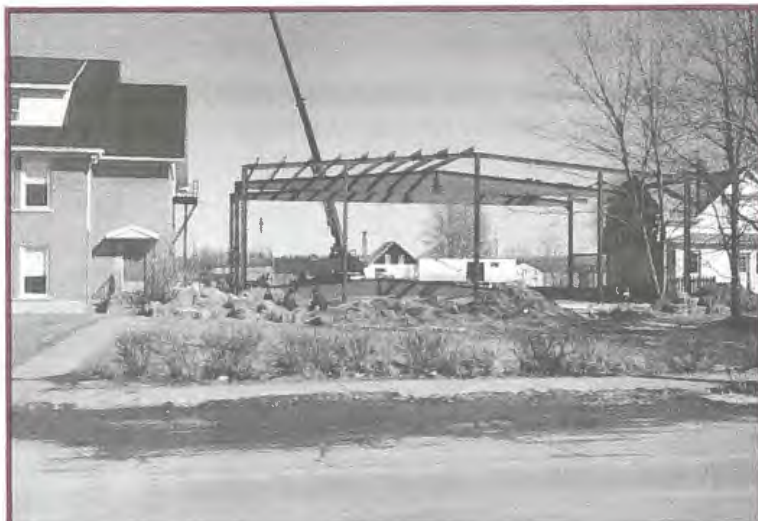
La construction du centre débute en septembre 1984.
