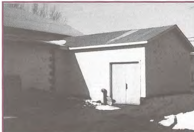
La première usine de filtration, annexée à la caserne des pompiers.
