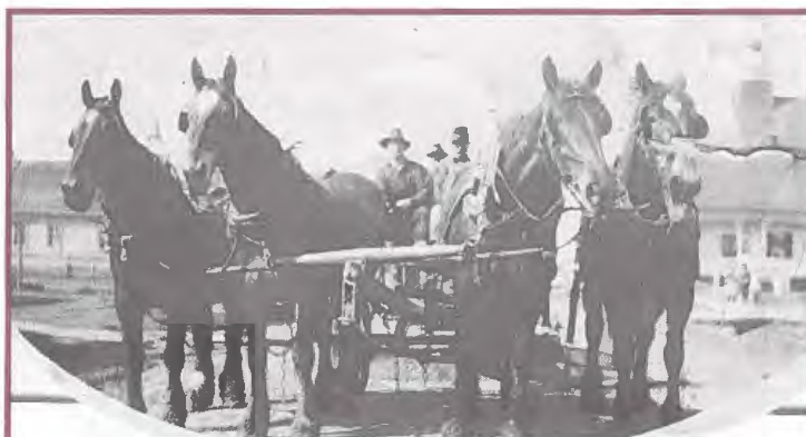
Construction de la rue principale. Deux paires (teams) de chevaux attelés à une gratte. On reconnaît Albéric et Albert Paquin.
