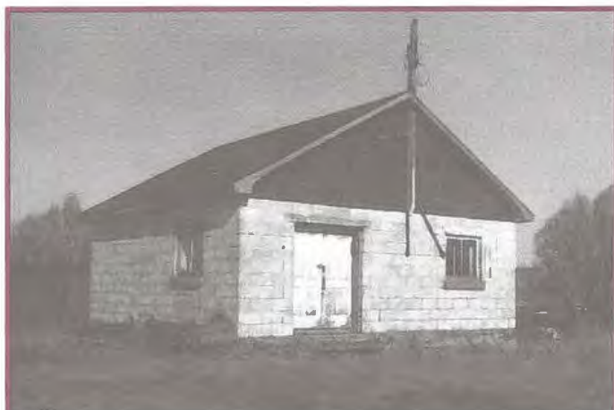
Réserve d'eau située sur la terre de Roger Trahan, au sud du village.
