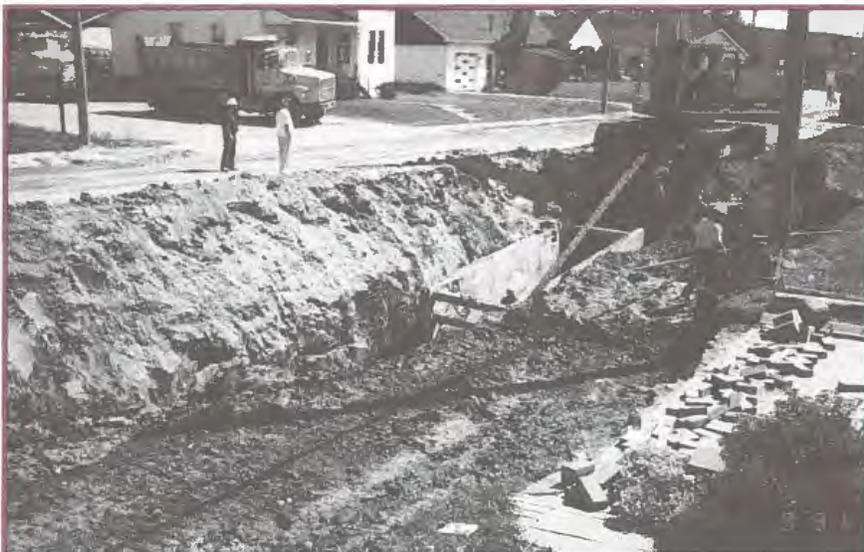
Travaux d'assainissement des eaux, en 1994, sur la route 101. Pose des tuyaux d'égout et du pluvial.
